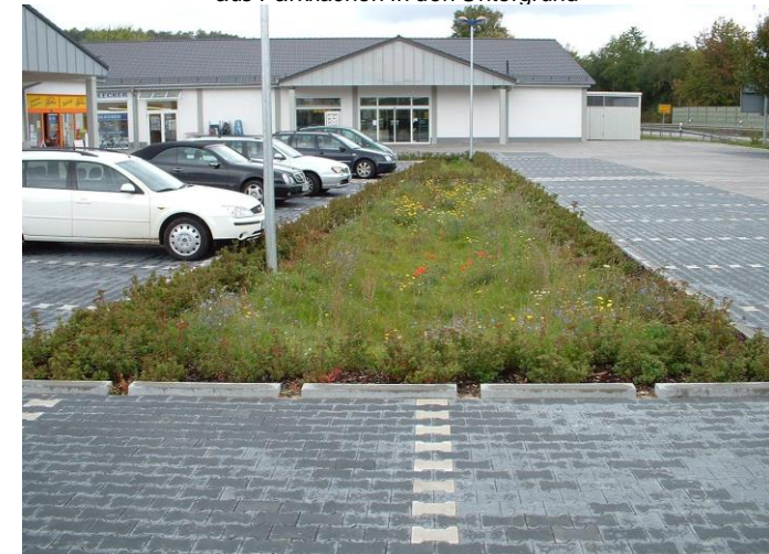
Beispiel für eine Versickerungsmulde zum Ableiten von Regenwasser aus Parkflächen in den Untergrund
