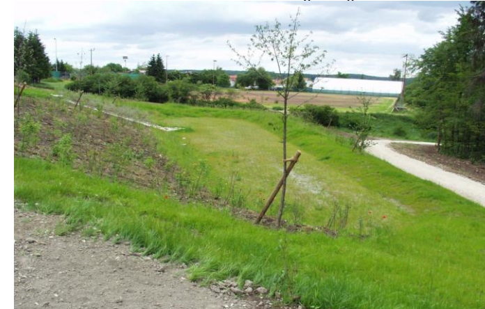
Beispiel für bewachsene Versickerungsmulde einer Großflächenentwässerungsanlage
